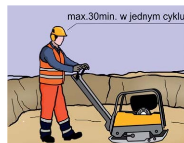
Rys. 1. Zagęszczanie gruntu ubijakami mechanicznymi
