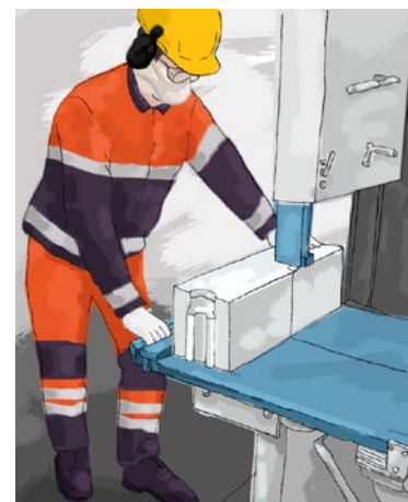
Rys. 6. Bezpieczeństwo i higiena pracy podczas piłowania cegieł
