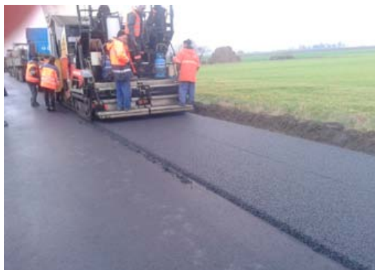
Rysunek 21 Rozkładanie mieszanki PA 8
