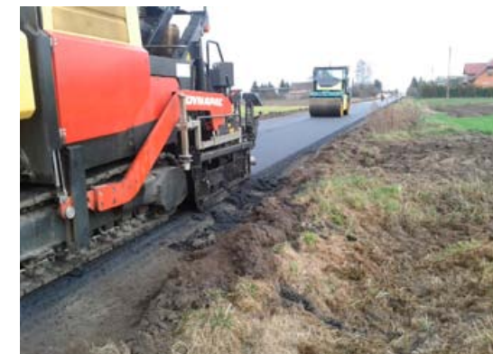
Rysunek 24 Zagęszczanie warstwy ścieralnej z mieszanki OGFC 8
