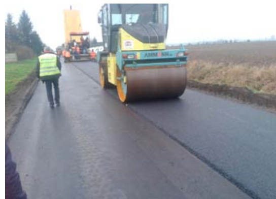
Rysunek 22 Zagęszczanie warstwy ścieralnej z mieszanki PA 8
