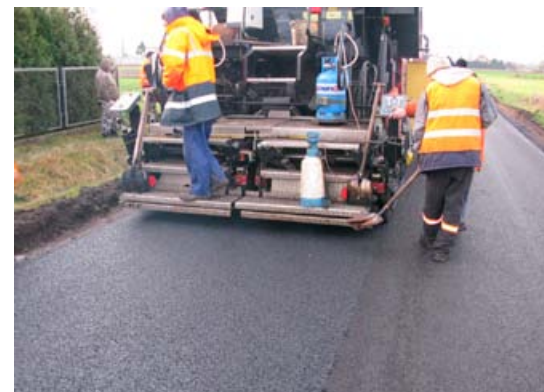
Rysunek 23 Rozkładanie mieszanki OGFC 8
