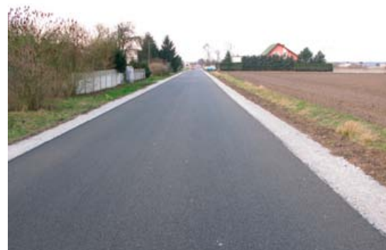
Rysunek 26 Warstwa pobocza z utwardzonego kruszywa
