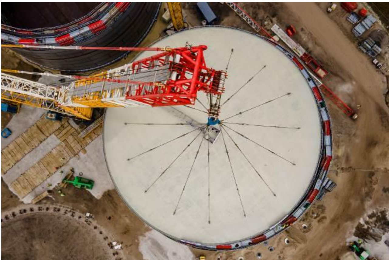
Budowa zbiorników PERN w Nowej Wsi Wielkiej
