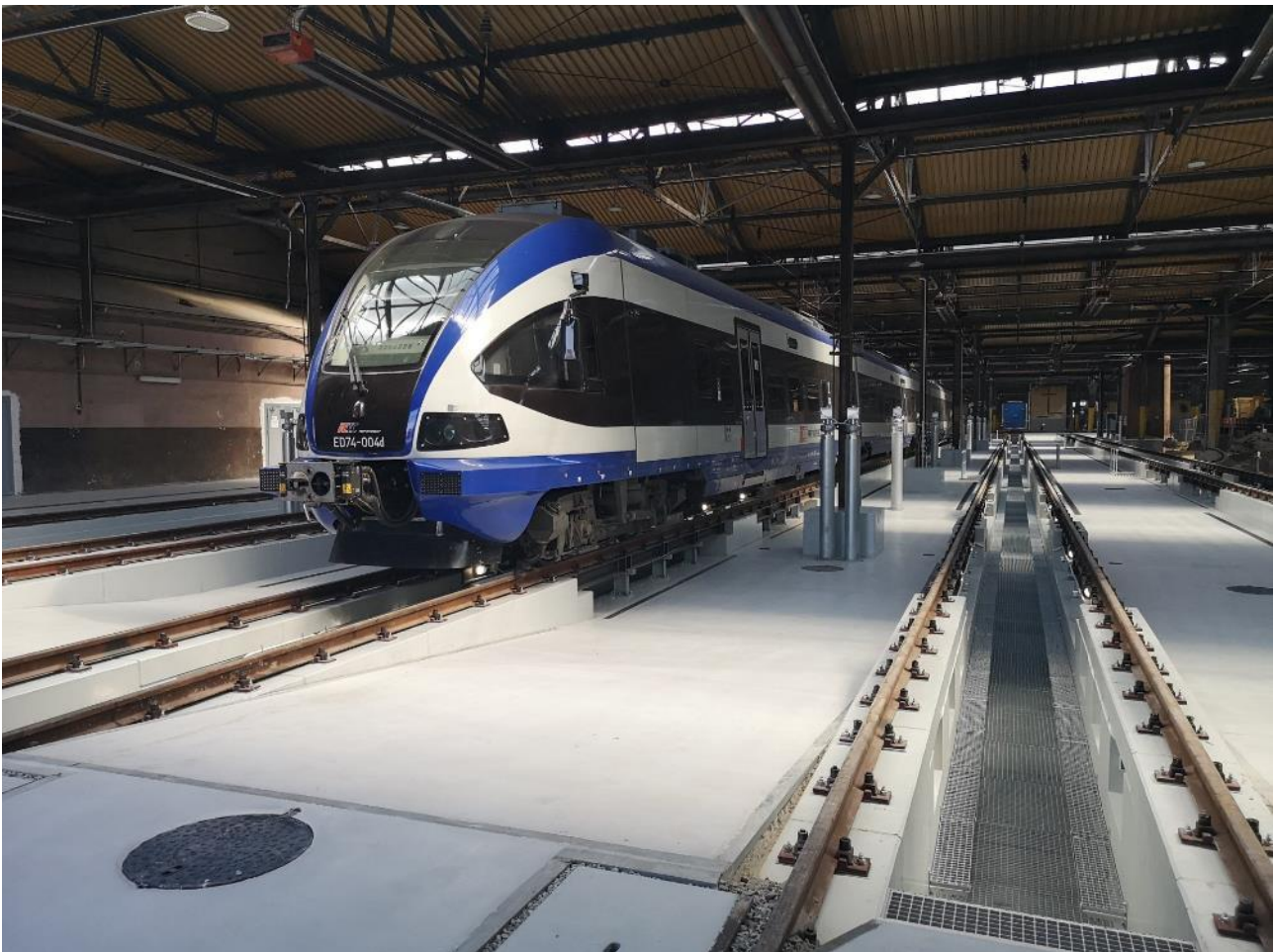
Hala Lokomotywowni PKP Intercity we Wrocławiu
