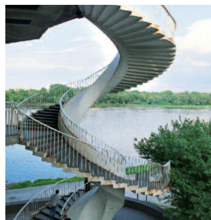
Most Gdański ma dwa poziomy. Z chodnika na Wislostradzie wchodzi się na niego po spiralnych schodach
