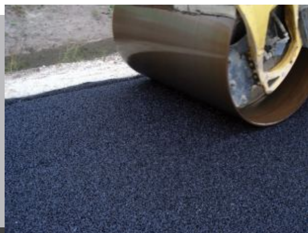
Zagęszczanie mieszanki mineralno-asfaltowej Asphalt mix compacting
