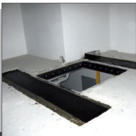
Wzmocnienie stropu żelbetowego laminatem z włókien węglowych w miejscu wykonanego otworu FRP strengthening system
