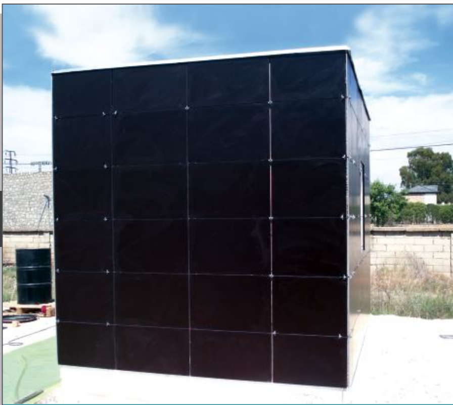
Obiekt demonstracyjny wykończony płytkami ceramicznymi z nanocząstkami Demonstration object with nanoceramic tiles
