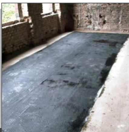
Wzmocnienie stropu żelbetowego laminatem z tkaniny węglowej FRP strengthening of concrete slab
