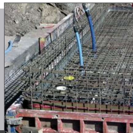
Zbrojenie płyty dennej prętami bazaltowymi (Park Fontann w Warszawie) Foundation slab reinforcement based on basalt composites (Fountain Park in Warsaw)
