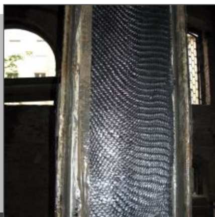
Wzmocnienie słupa stalowego laminatem z tkaniny węglowej Steel structure strengthening by carbon-fibre based composite
