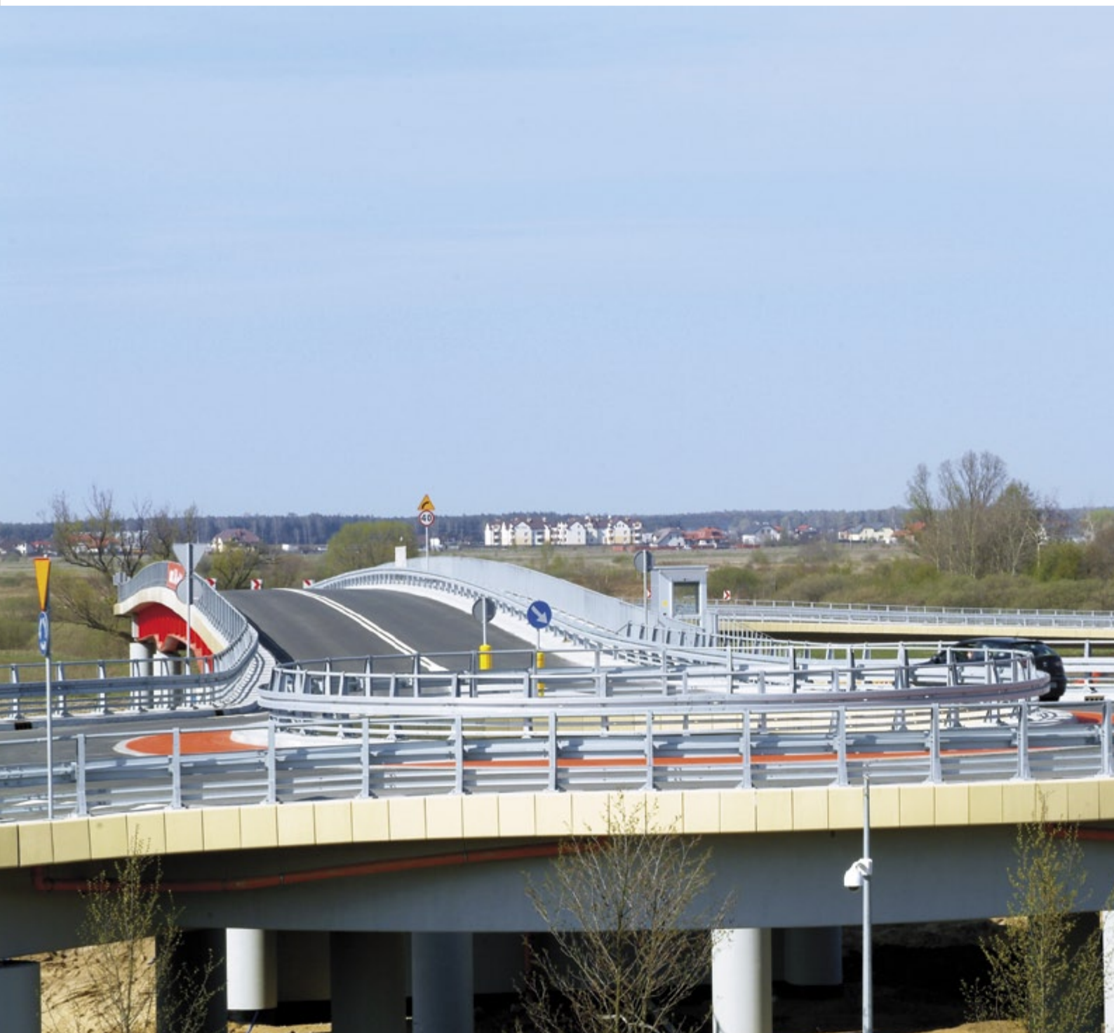
Wiadukt dojazdowy nad Trasą Toruńską w Markach pod Warszawą / Access viaduct over route Trasa Toruńska in Marki near Warsaw
