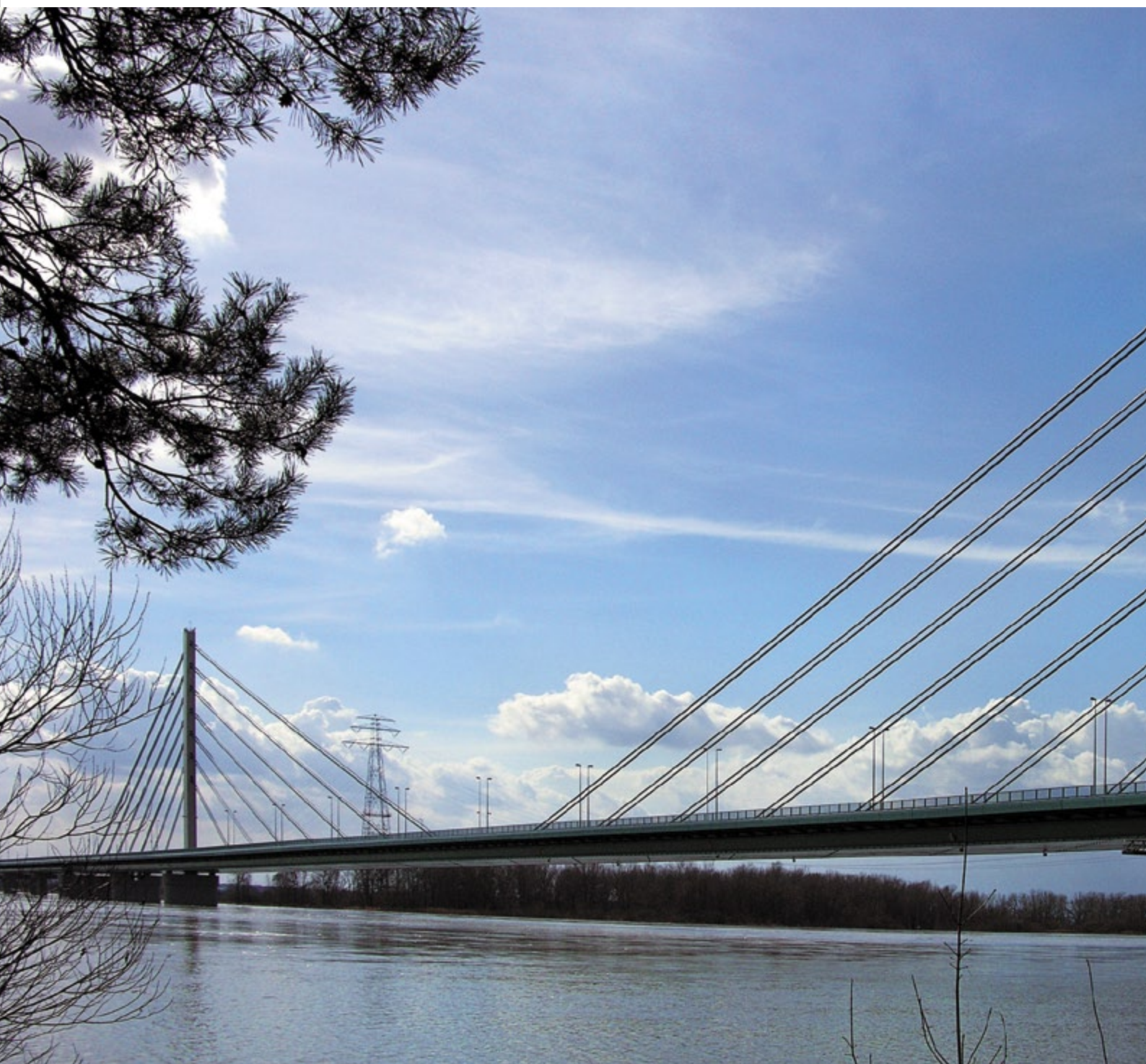
Most przez rzekę Wisłę w Plocku / Bridge over Vistula River in Plock
