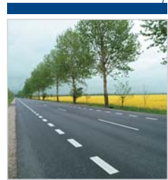
Prace drogowo-mostowe na odcinku Gdańsk-Kieźmark w ciągu drogi krajowej nr 7 Gdańsk-Warszawa-Chyżne Road and bridge works on the section Gdańsk-Kieźmark of the national road No 7 Gdańsk-Warszawa-Chyżne
