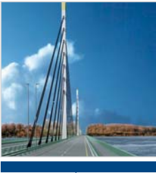
Most na rzece Wiśle w Płocku Bridge over the Vistula in Płock
