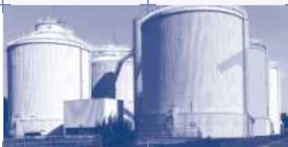
Oczyszczalnia ścieków Czajka w Warszawie
