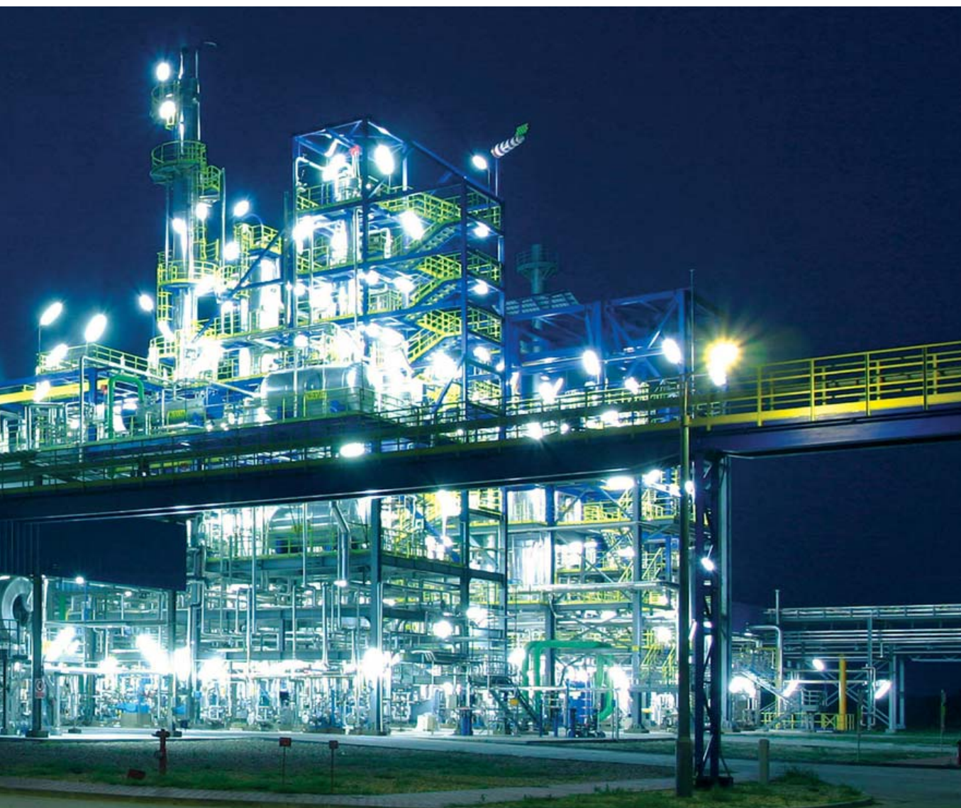
Kontrakty dla Zakładów Azotowych „Puławy” S.A. Contracts in Nitrogen Plant „Puławy” S.A.
