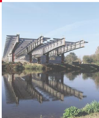
Obwodnica Poznania (A-2) - most drogowy przez Wartę
