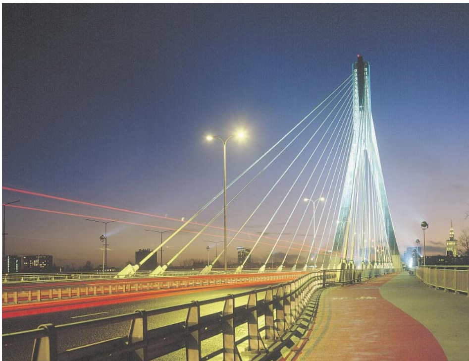
Most Świętokrzyski w Warszawie Świętokrzyski Bridge, Warsaw
