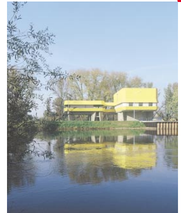
Ujęcie wody Dębina dla Poznania Water intake Dębina, Poznań
