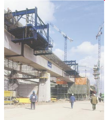
Most Siekierkowski w Warszawie Siekierkowski Bridge, Warsaw
