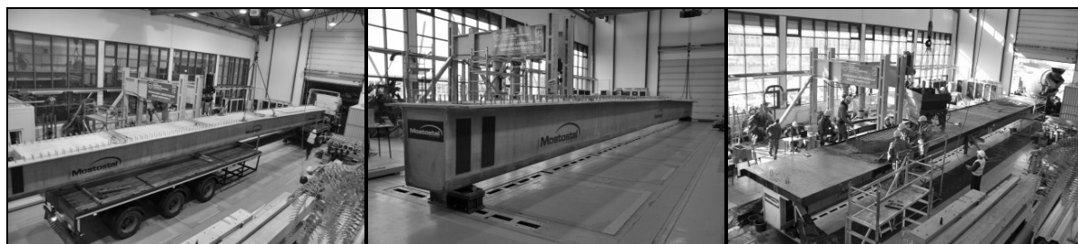
Rys. 12. Dźwigar kompozytowy: od lewej: transport do hali laboratoryjnej, ustawienie na docelowych łożyskach oraz etap betonowania płyty pomostu;
