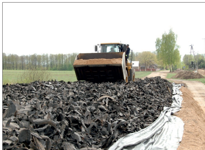
Fot. 9. Wstępne zagęszczanie warstwy nasypu ze strzępów gumowych
