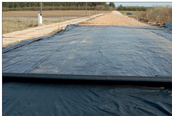
Fot. 7. Rozkładanie geomembrany i geotekstyny
