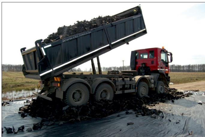
Fot. 8. Rozkładanie strzępów gumowych na geotkaninie
