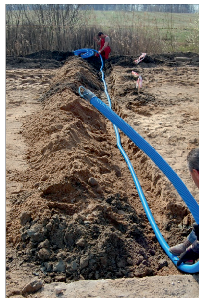
Fot. 6. Instalacja rury będącej elementem systemu do pomiaru osiadań nasypu
