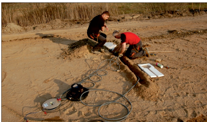
Fot. 5. Instalacja czujników parcia pod nasypem
