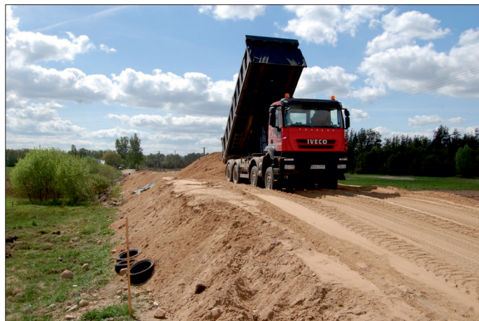
Fot. 10. Końcowy etap formowania górnej części nasypu
