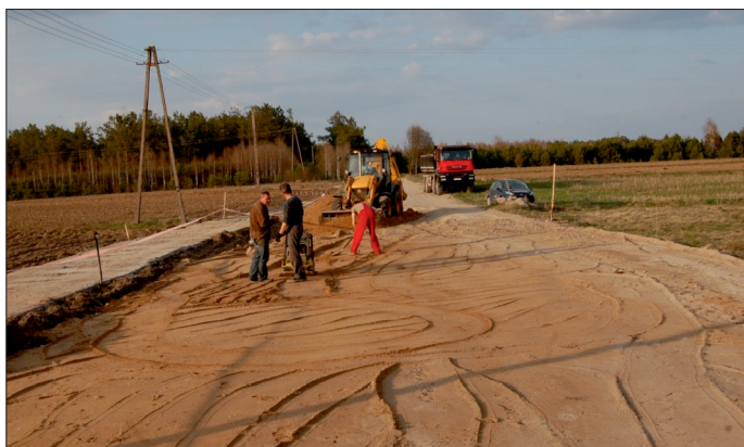
Fot. 4. Przygotowanie podłoża pod nasyp drogowy
