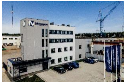
Siedziba Mostostal Kielce S.A
