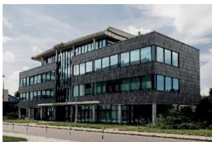
Siedziba AMK Kraków S.A
