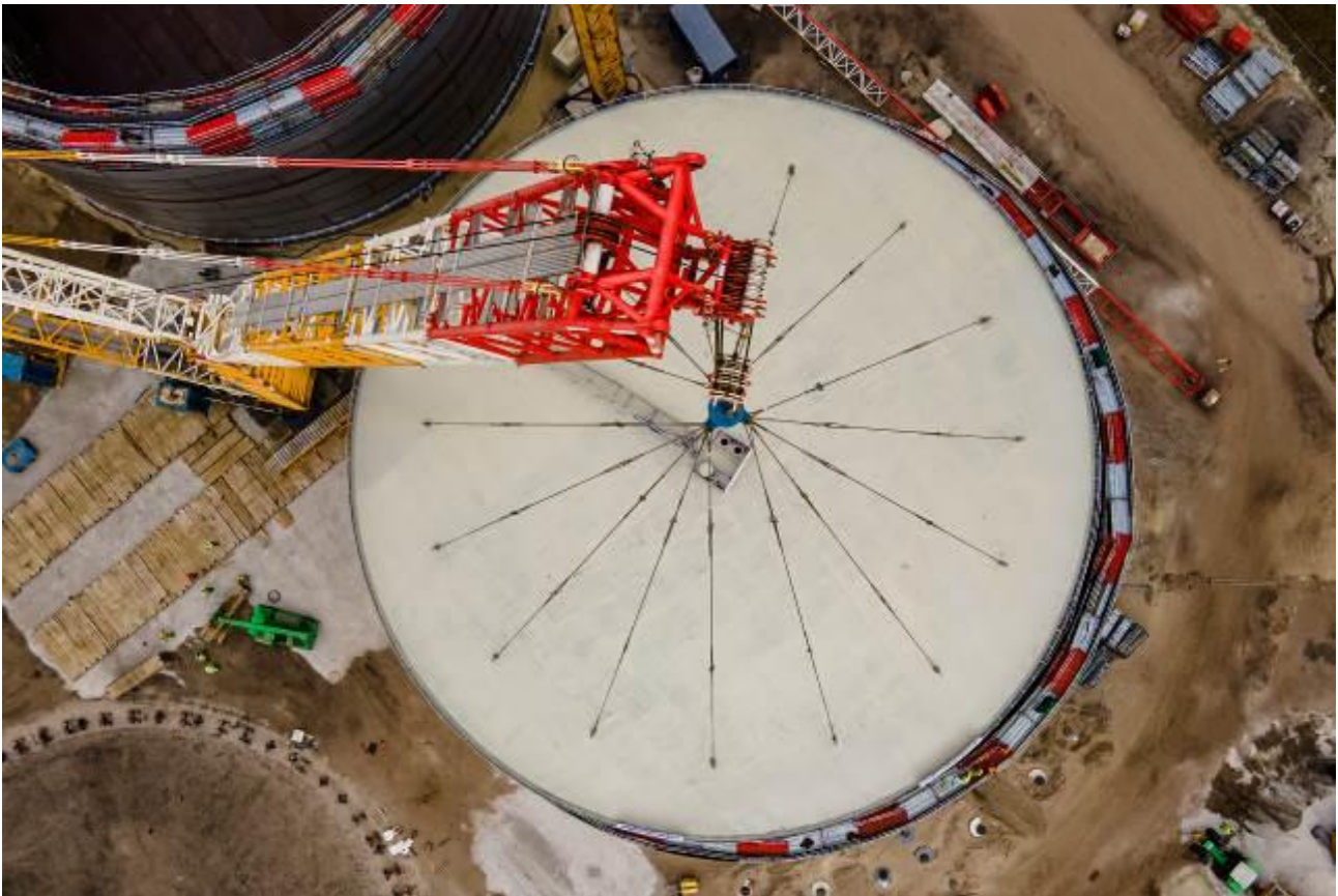
Budowa zbiorników PERN w Nowej Wsi Wielkiej
