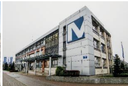
Siedziba Mostostal Płock S.A.
